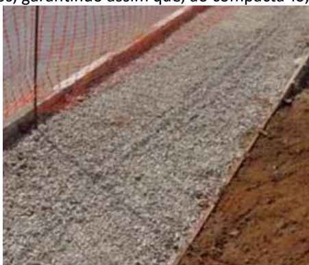
Figura 7 – Espalhamento da camada de Brita
