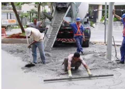
Figura 8 – Recebimento e espalhamento do concreto.
